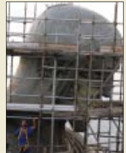
Rio de Janeiro restoration
